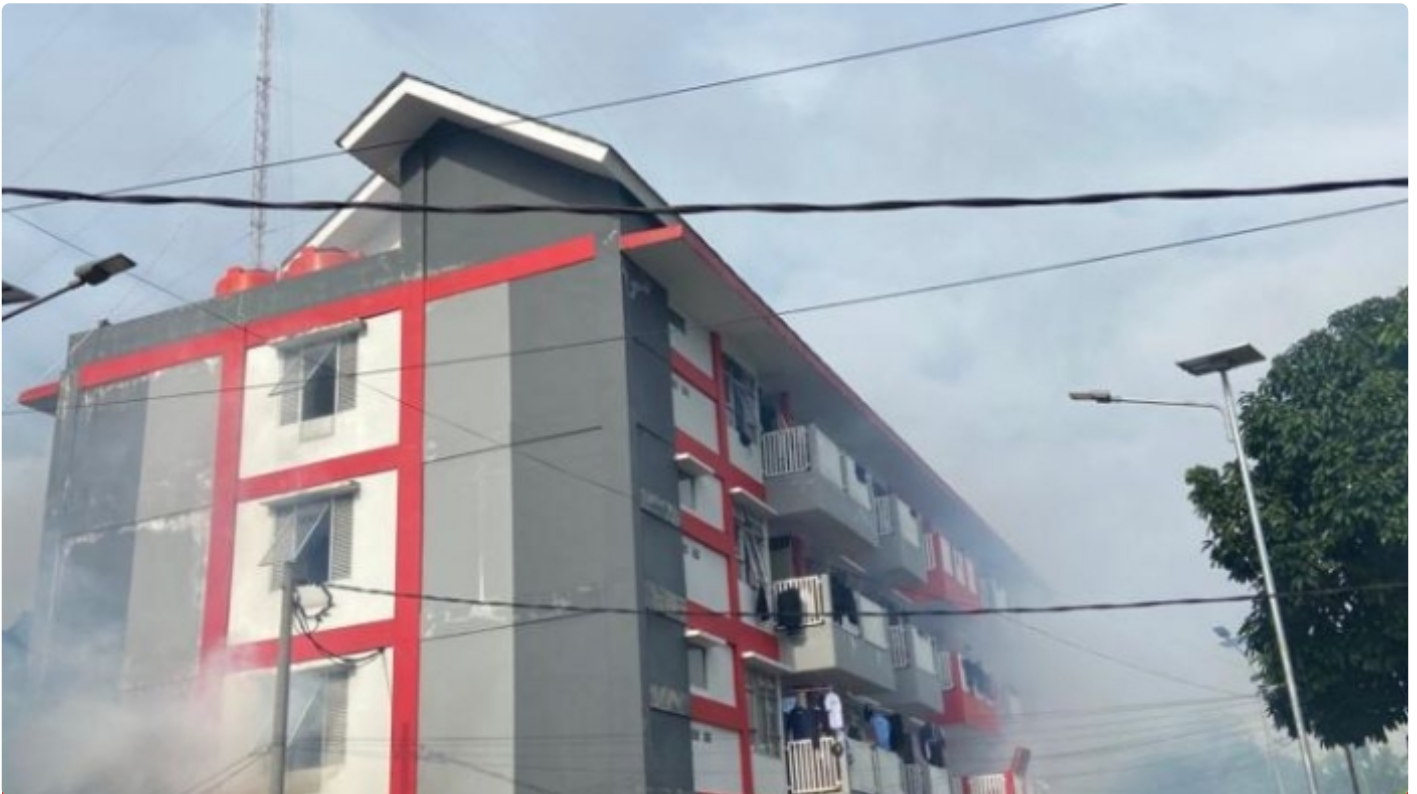
Pelaksanaan Fogging dalam mengantisipasi penyebaran DBD di area sekitar rumah susun dan Wisma tempat tinggal Taruna Poltekip Angkatan 53
